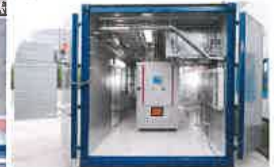
Bsp. Innenansicht Container-BHKW
