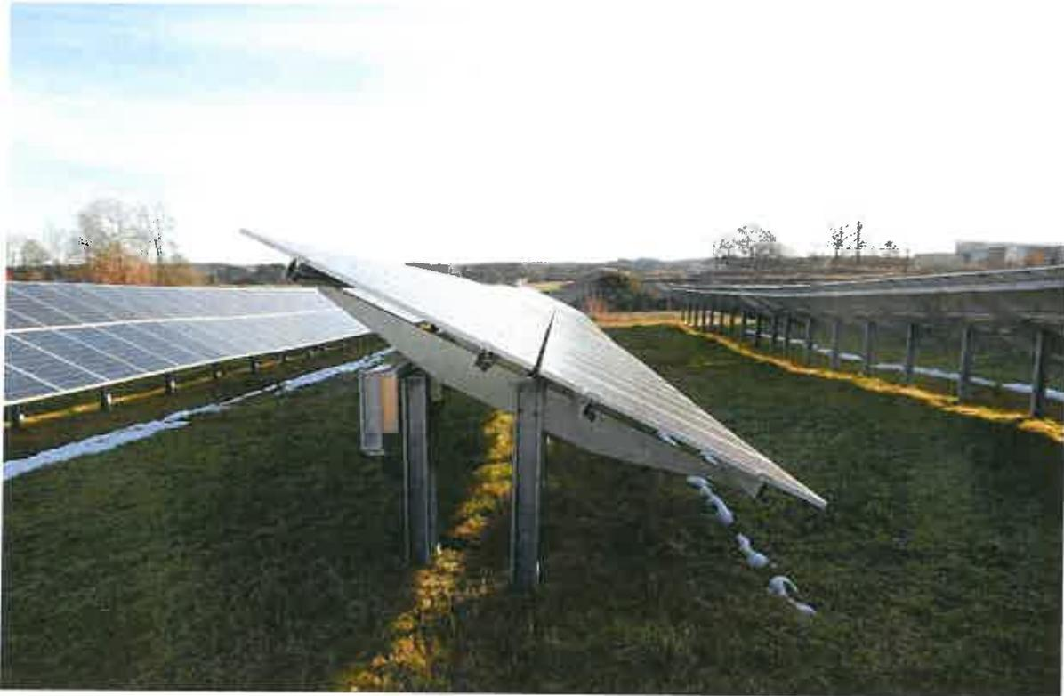
Abbildung 8: Beispiel für eine Freiflächenphotovoltaikanlage (Gemeinde Fuchstal)
